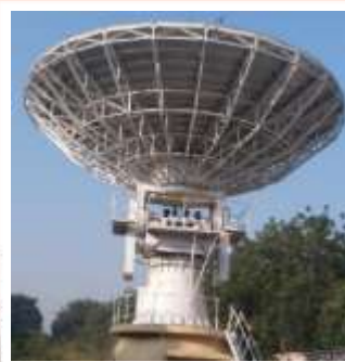
GISAT-2 Ku-band 11 m Antenna GISAT-1 Ku-band 9.1 m Antenna
